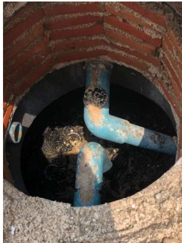
บ่อบำบัดน้ำเสียแบบไร้อากาศที่ 1 และ 2
